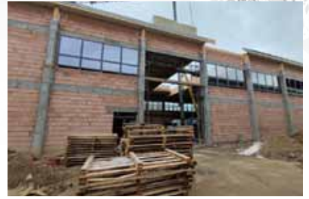
Budowa sali sportowej w Janowicach
